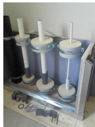
Demonstrationsexempel av tappvattenschakt i Vårberg
