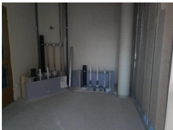
Demonstrationsexempel av tappvattenschakt i Vårberg
