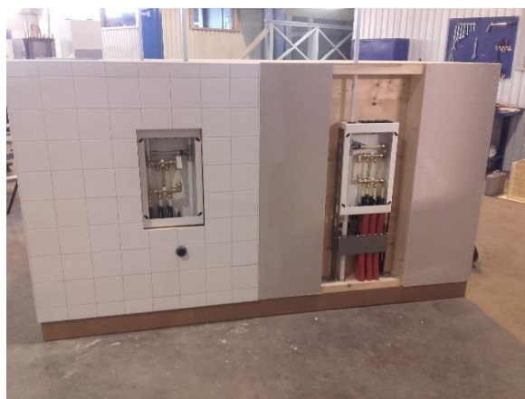
Prefabricerade stamfördelarskåp
