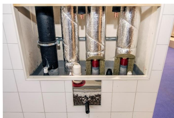
Tappvattenschakt med tät schaktbotten
